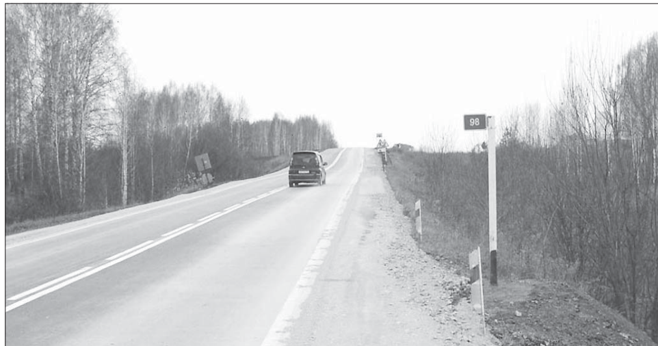
Отремонтированный участок дороги Тогучин—Карпысак.
